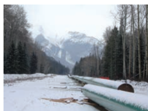
Préparation d'un pipeline pour une installation sous terre
