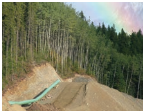
Sections soudées d'un pipeline Photo : Régie de l'énergie du Canada
